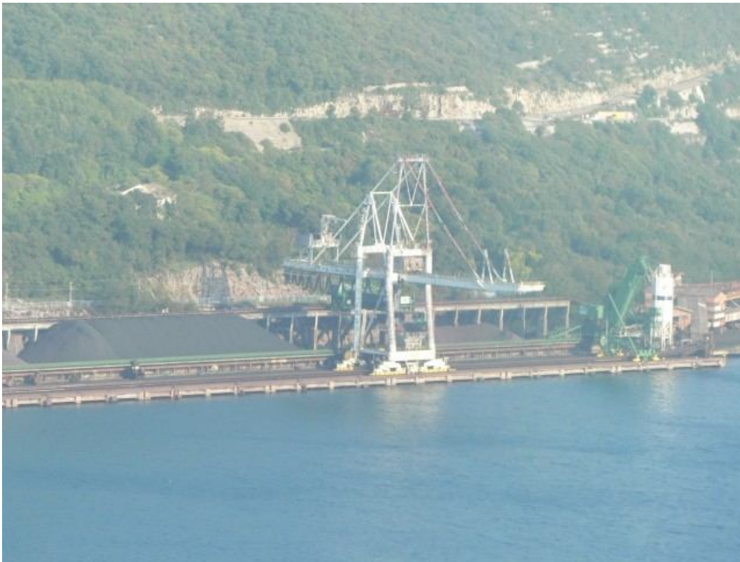
Pristanište za prekrcaj sipkog tereta u Bakarskom zaljevu
